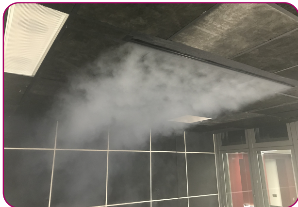
DF-LIT-E-3.0 horizontal discharge
