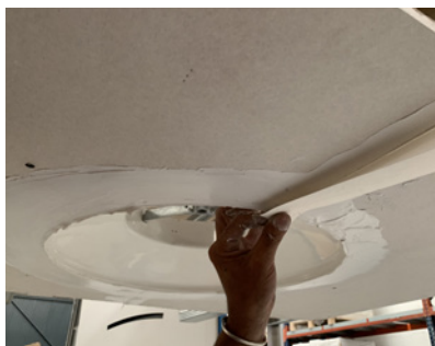
Con aplicación de "venda antiagrietamiento"
