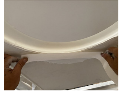
Con aplicación de "venda antiagrietamiento"
