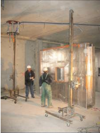
1 - Preposicionar el panel en su ubicación
