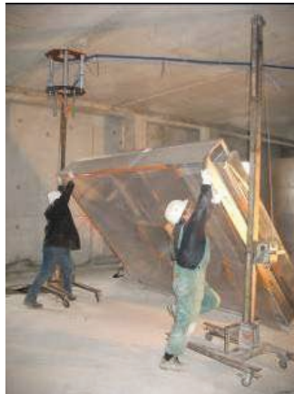
2 - Bascular el panel sobre la zona de elevación
