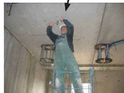
2. Colocar taco de anclaje
