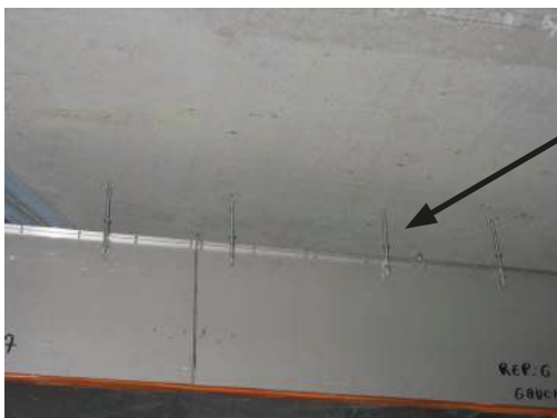
Fijar con arandelas y tuercas
